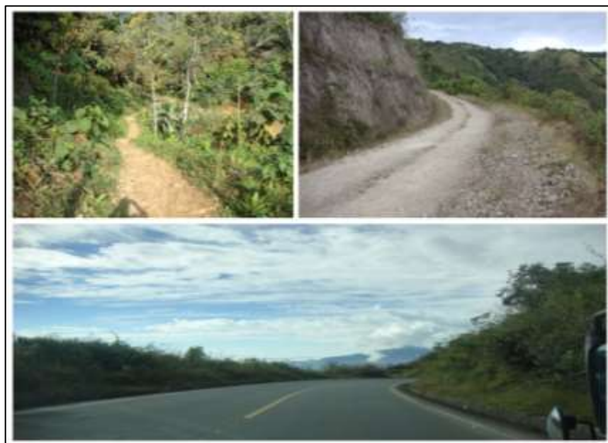
FIG V.55 Vías: Sendero, Lastrada y Pavimentada
